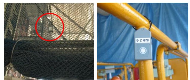
Photo 3 RFID タグの付与状況 (左：階数, 右：高所作業車) Attached RFID Tags
