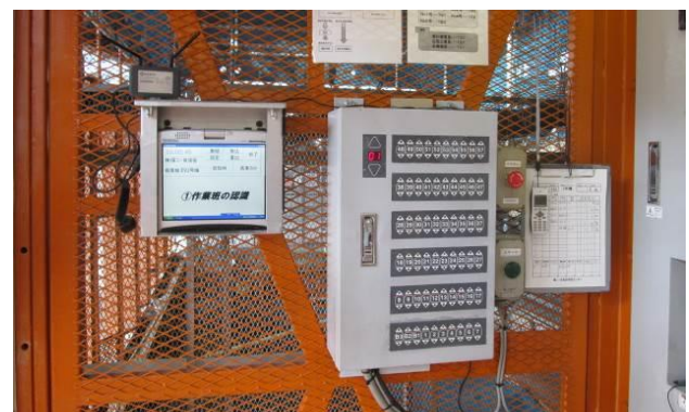
Photo 2 実績収集 PC の設置状況 Touch-Screen PC in Temporary Elevator
