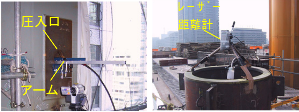
(a)圧入口設置の場合 (b)柱頭部設置の場合 Photo2 レーザー距離計の設置 Installation of Laser Range Finder
