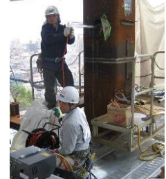
Photo5 管内カメラの操作 Operation of Cable Camera
