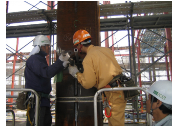
Photo4 レーザー距離計の設置 Installation of Laser Range Finder
