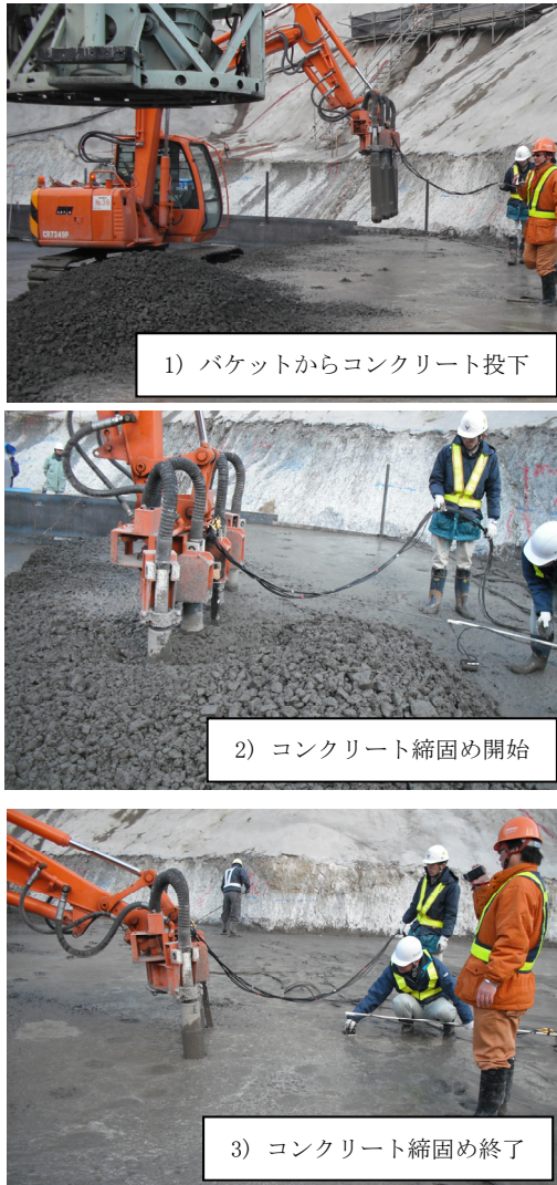
Photo 1 ダムコンクリートの締固め状況 The Compaction Situation of the Dam Concrete
