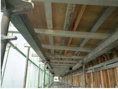
Photo 8 型枠の設置状況 Form Timbering
