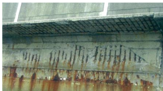
Photo 5 リニューアル前の状況 Shore Protection Structure before Renewal
