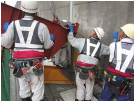
Photo 9 打込み状況 Placement Using Bessel
