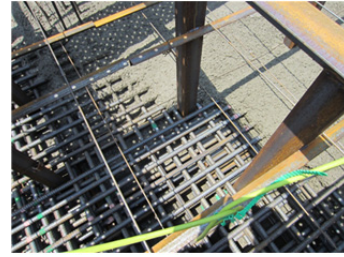
Photo 3 流動化コンクリートの打込み状況 Placing of Flowing Concrete
