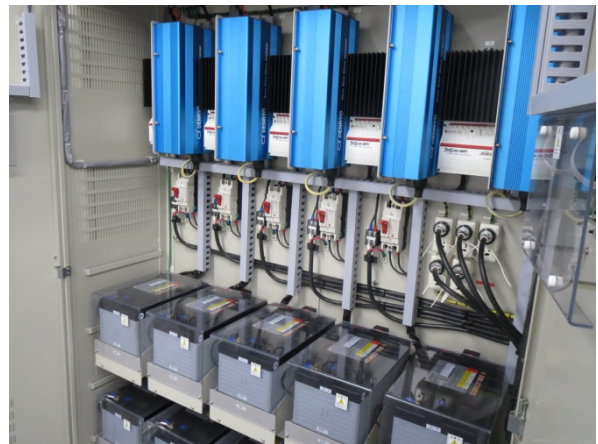
Photo 4 オフグリッド型の太陽光発電制御盤 Control Unit of the Solar Off-grid System
