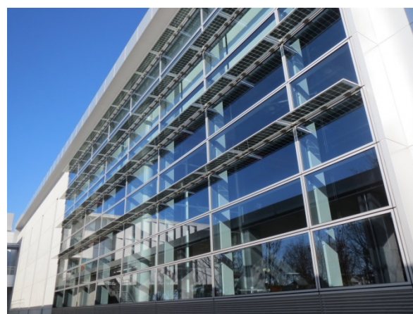
Photo 3 庇状の太陽電池とカーテンウォール Photovoltaic as Eaves and Curtain Wall
