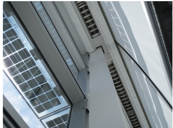
Photo 5 インターロック式換気システム とロールスクリーン Interlocking Ventilation System and Rolling Screen
