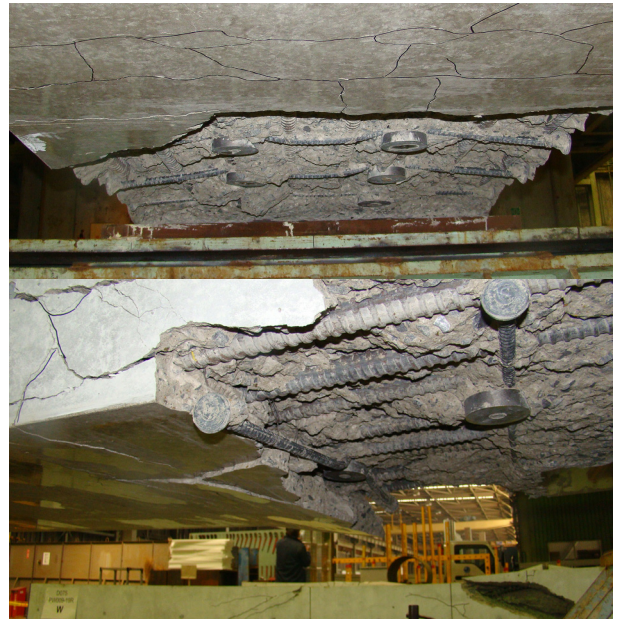
Photo 9 配力筋の変形状況 (上 : D075PW019-19, 下 : D075PW013-23) Status of Bending Distributing bars (Upper : D075PW019-19, Lower : D075PW013-23)
