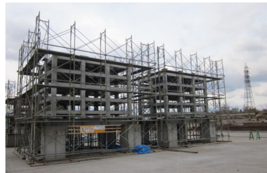
(c) 第2, 3ブロック Photo 1 試験体の製作状況 Construction Process of the Test Specimen
