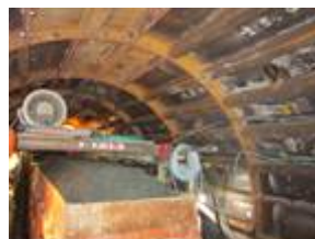
ズリ鋼車による搬出状況
