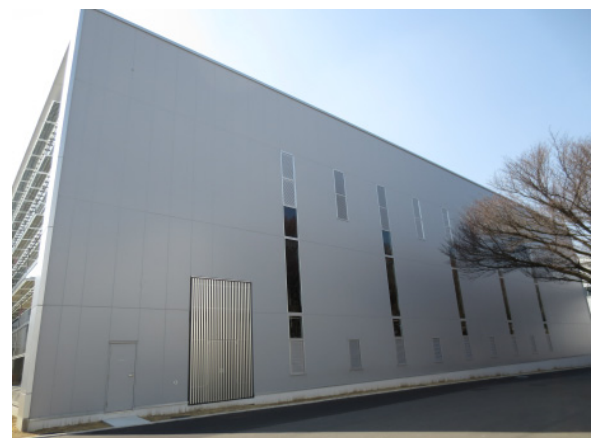
Photo 4 実適用例 (物件名; 技術研究所 オープンラボ 2) Example of Application(Multipurpose Laboratory 2, Obayashi Corporation Technical Research Institute)
