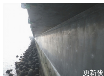
Photo 17 スリムクリートによる護岸の更新 Revetment Renovation Using “Slim-Crete®”
