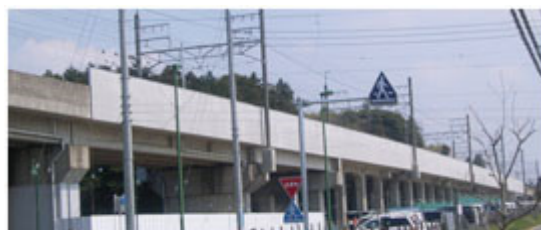
Photo 4 「スリムクリート ® 」による強風対策 Strong Wind Countermeasure by a Method of “Slim-Crete ® ” Construction
