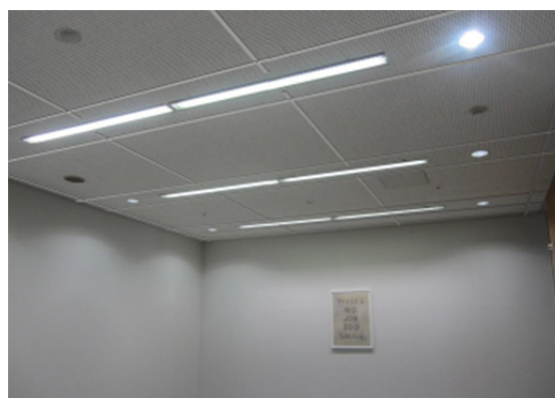
Photo 19 フェイルセーフシーリング® （フラットバー+ネットタイプ） Fail-Safe Ceiling® (Flat Bar + Net Type)
