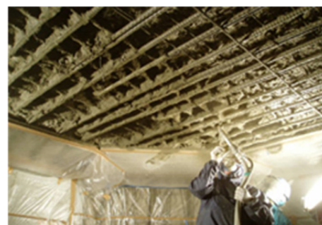
Photo 13 ジョットクリート工法の施工状況 Construction of "JOT's-Crete" Method
