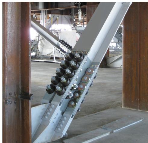
Photo 1 ブレーキダンパー Brake Damper
