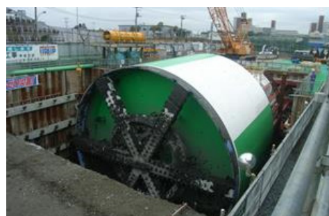
Photo 6 URUP 工法による 大断面トンネル施工 Construction of Large Cross Section Tunnel by “URUP Method”
