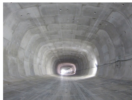
Photo 11 耐火型高機能 SFRCセグメントの適用例 High Functional Fire Resistance Segment
