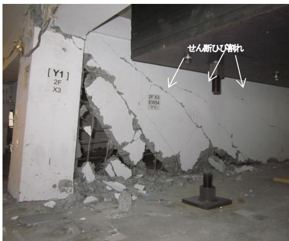
Photo 5 2階耐震壁の損傷
