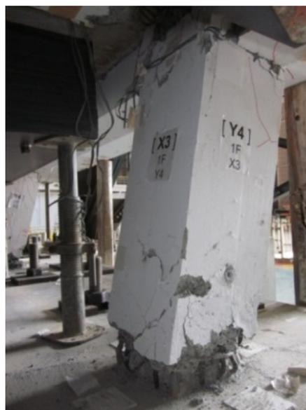
Photo 6 1階独立柱の損傷
