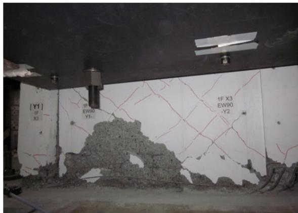
Photo 4 1階耐震壁の損傷
