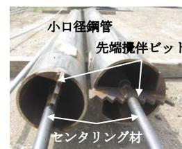
Photo 1 杭先端部の構造
