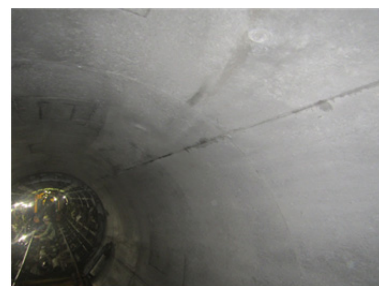
Photo 6 コンクリート表面の仕上がり状況 Finishing of Concrete Surface
