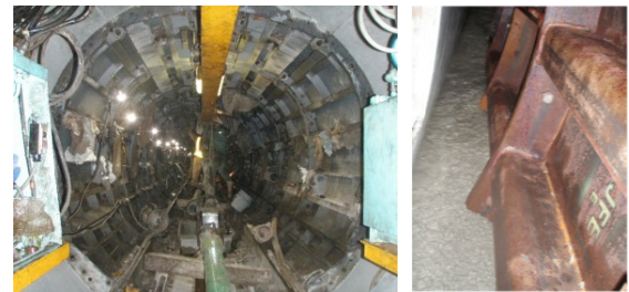
Photo 5 コンクリートの打込み状況 Concrete Placement in Steel Form
