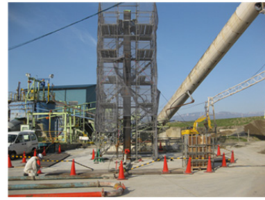
Photo 1 実大施工実験 4)
