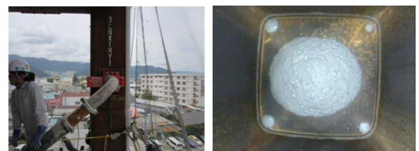
Photo 3 CFT 造の鋼管内の打込み状況
