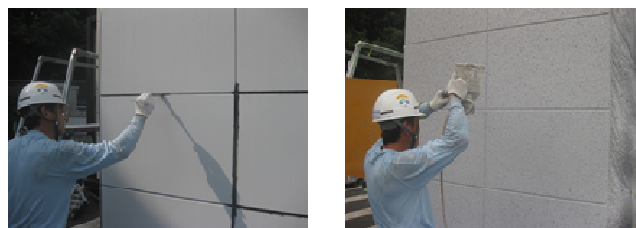
(4) パネルの塗装
