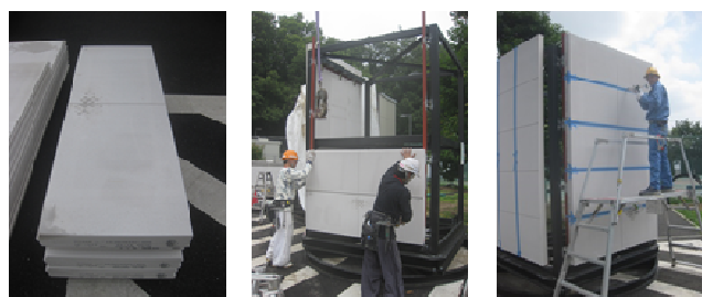
(1) 目地溝の加工 (2) パネル取付け (3) パネル間シーリング
