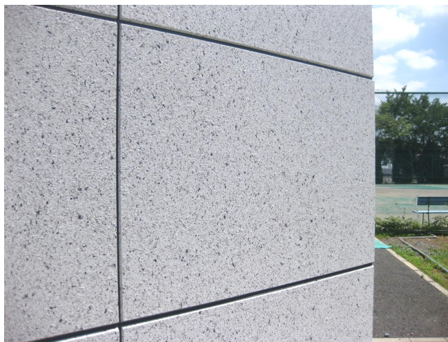
Photo 3 石材調リニアートパネルの仕上り状況 Finish of Field Used Stony Linear Panel
