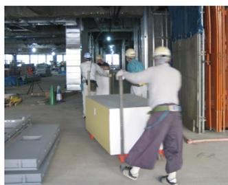
Photo 2 台車による搬送 Conveyance by Flatcar
