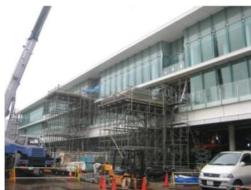
Photo 1 荷揚げステージとラフターによる揚重 Stage and Crane on the Jobsite
