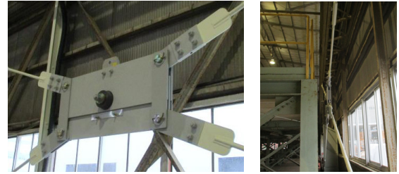
Photo 5 大林組東京機械工場への適用状況 Status of Application
