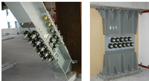
(a) ブレース型 (b) 間柱型
