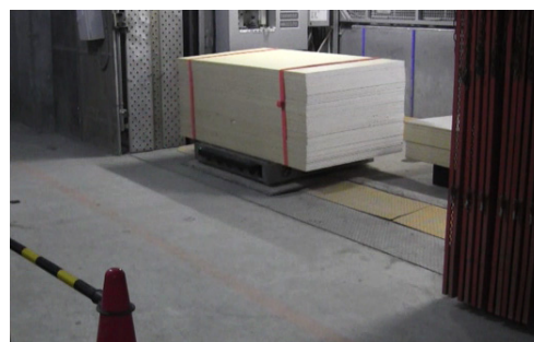
Photo 5 工事用 EV への乗込み状況 Getting into the Elevator
