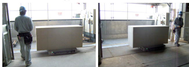
Photo 9 低床式 AGV 遠隔操作 Low-Flatbed AGV Remote Control
