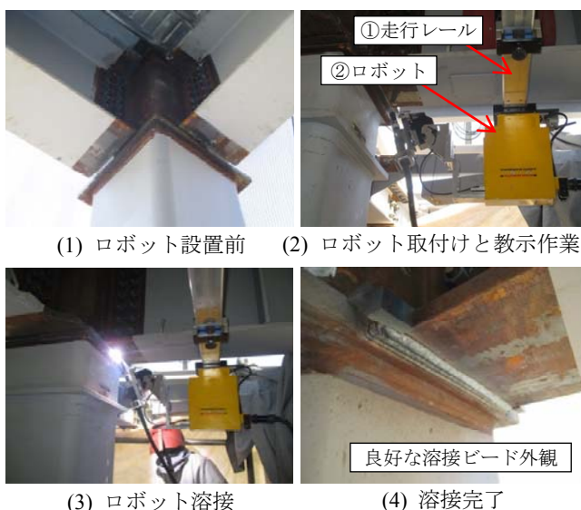
Photo 2 ロボット上向溶接手順 Robot Overhead Welding Procedure
