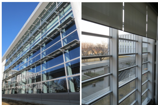
Photo 1 外装ガラスカーテンウォールの外観と内観 Appearance of the Glass Curtain Wall
