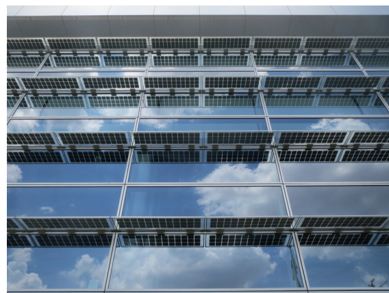
Photo 2 ガラスカーテンウォールに取り付けられた太陽電池 Building-Integrated Photovoltaic Mounted on the Glass Curtain Wall
