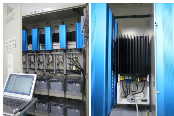
Photo 3 オフグリッド型の太陽光発電制御盤と充電コントローラ Control Unit of the Solar Off-Grid System and the Charge Controller
