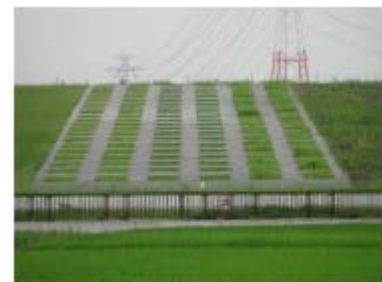
Fig. 19 チップクリート緑化工法の例 Chip-Crete Greening Method
