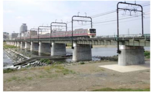
Fig. 7 スリムクリート（橋脚基礎の洗掘防止） Slim-Crete
