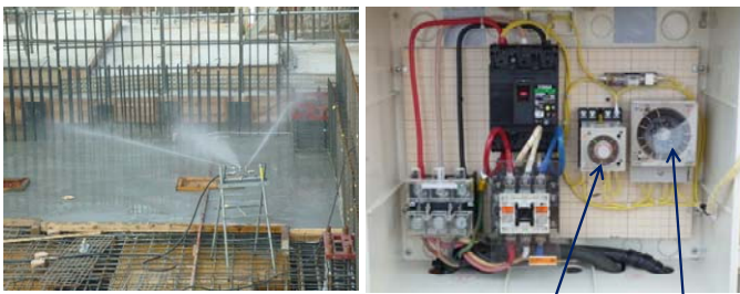
Photo 2 現場での実施例 (左: 散水状況 右: 制御盤) Practical Example in the Construction Site
