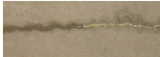
Photo 2 従来工法施工箇所の再漏水状況
