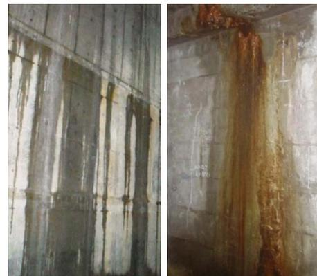
Photo 1 地下躯体漏水の例
