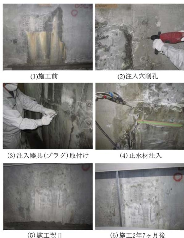
Photo 10 建築構造物へのミクストグラウト適用状況
