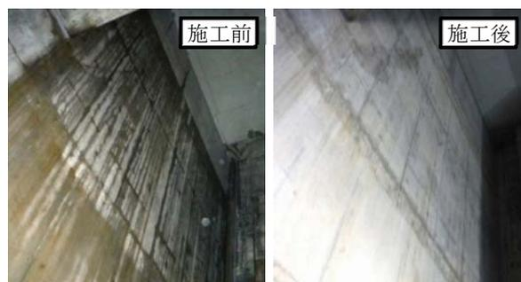
Photo 11 土木構造物へのミクストグラウト適用状況
