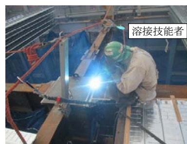
(1) 技能者による手動溶接 (従来技術)
