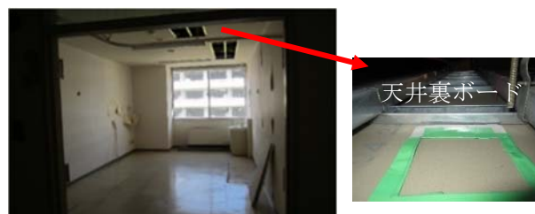
Photo 2 調査した部屋 Investigation Location
