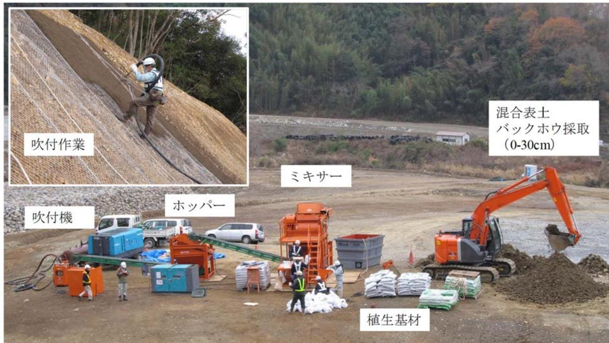
Photo 4 表土を利用した吹付緑化の試験施工状況
