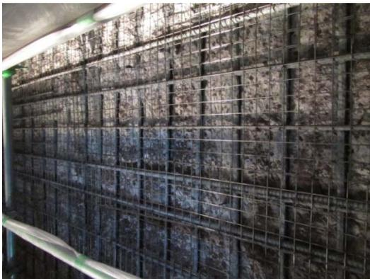
Photo 14 吹付け前の状況(壁面)
