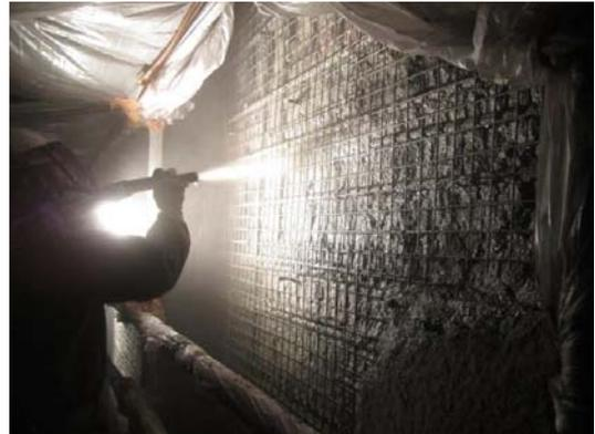
Photo 15 吹付けの状況(壁面)
