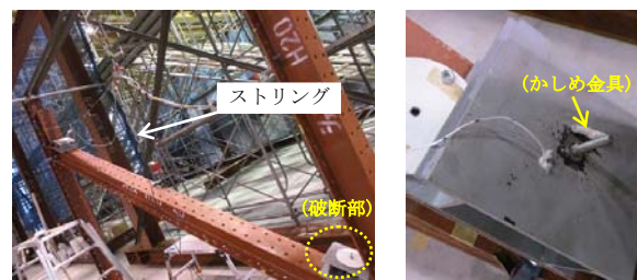
Photo 3 ストリング部の破断状況 [ES30-35-1] Photos of Damaged String [ES30-35-1]
