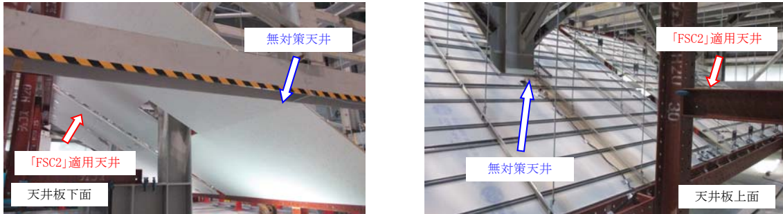
Photo 5 試験体設置状況：「ストリングタイプ」 Test Specimen of “String” Type FSC2
