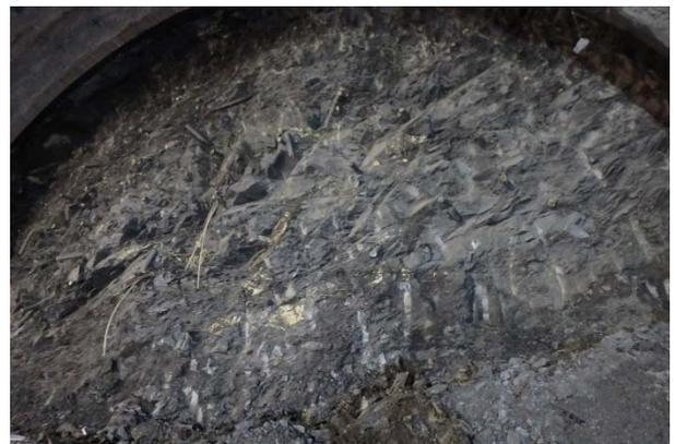
Photo 3 Cトンネルの切羽写真(頁岩, 粘板岩)
