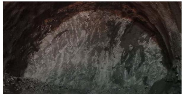
Photo 1 Aトンネルの切羽写真(砂岩, 頁岩)
