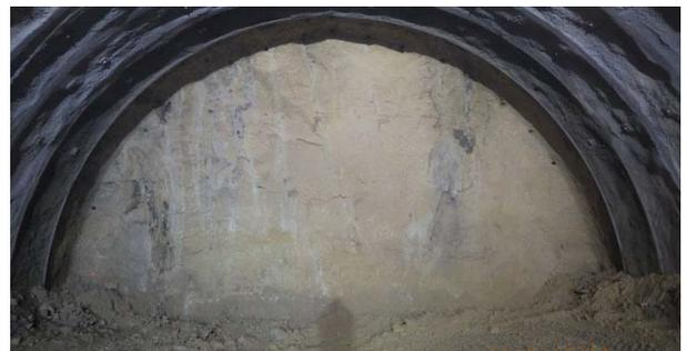
Photo 2 Bトンネルの切羽写真(凝灰岩)
