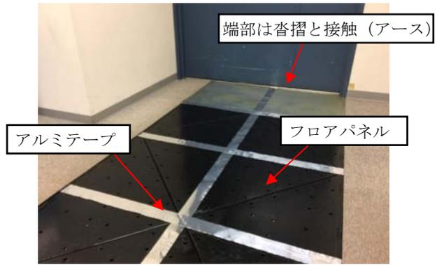
Fig. 2 アルミテープによる床の導電化
