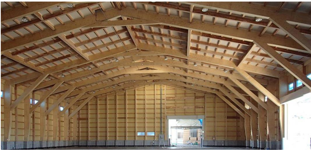
Fig. 3 オメガウッドを用いた構造物 A Structure made of Omega Wood
