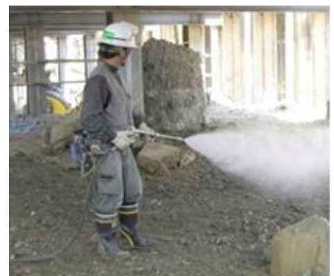
Fig.6 オイルクリンの散布 "Oilclean" Spraying
