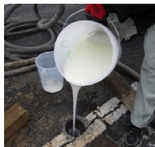
Photo 3 改良型クロロクリン S の充填状況
