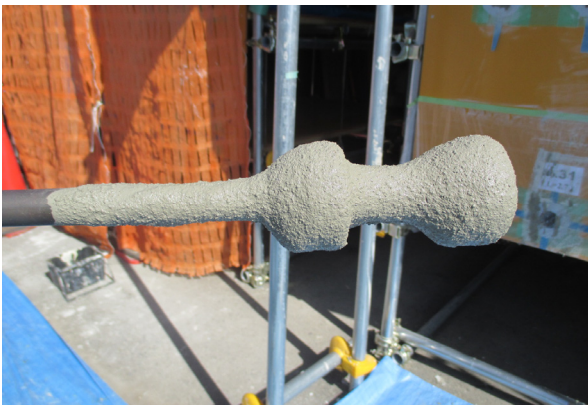
Photo 15 プレウェットの状況(先端のみ) Mortar Pre-Wetting (Tip Only)
