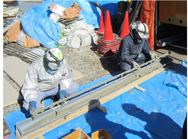
Photo 14 プレウェットの状況(全長) Mortar Pre-Wetting
