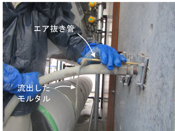
Photo 7 斜め上向きにおけるグラウト状況 Mortar Leak in case of Upward Slope Grouting
