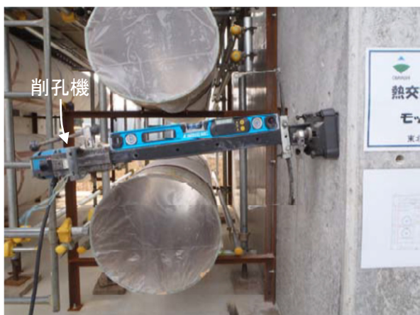
Photo 6 斜め上向きにおける削孔機セット状況 Side View of Core-Drill Set at Upward Slope
