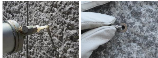
3) アンカーピン中空部へのエポキシ樹脂充填と化粧キャップの取付け
