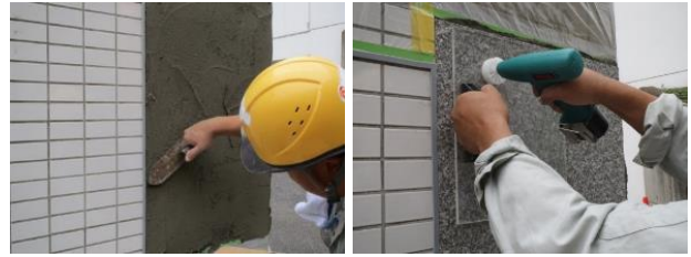
1) ポリマーセメントモルタルの塗付けとシート材の張付け
