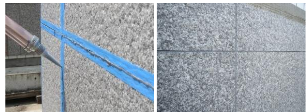
4) シート材とシート材の間の目地へのシーリング材の充填状況と仕上がり状況
