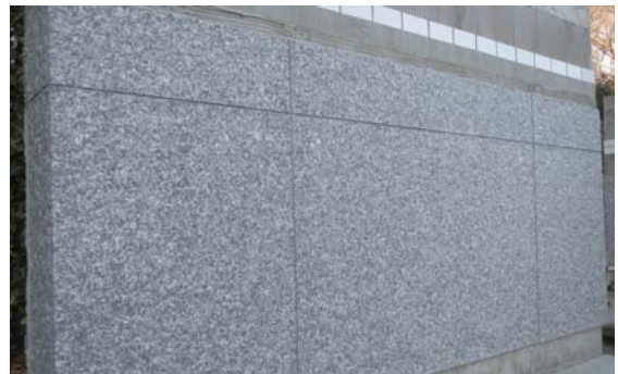
Photo 1 リニューフェイスによる外壁モックアップ “Renew-face” Applied to a Wall Mockup
