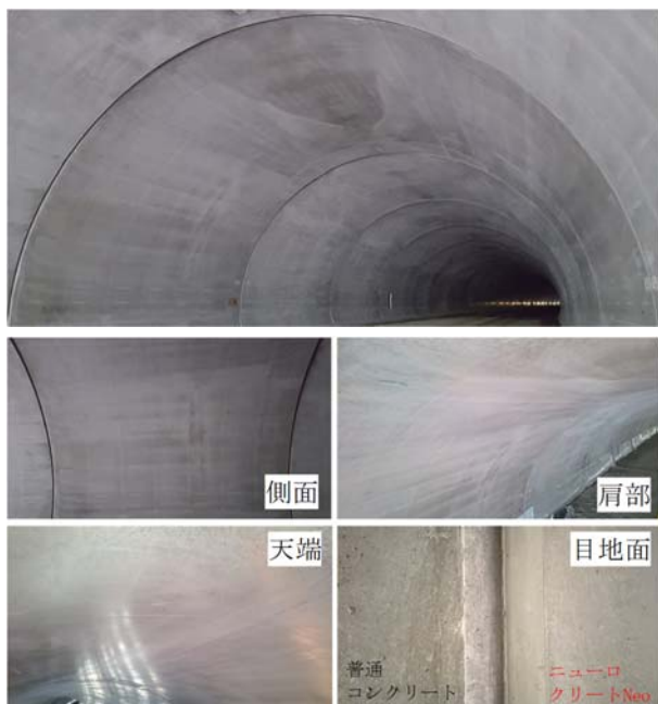
Photo 4 ニューロクリートNeoで構築した覆工の外観 External of Lining Built by Neuro-Crete Neo
