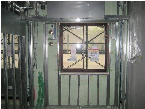
(a) 内装工事中の工事写真
