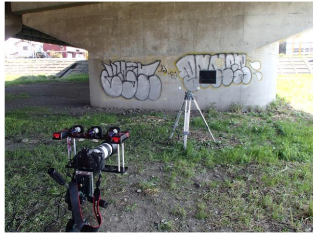
Photo 8 現場でのキャリブレーション On-site Calibration
