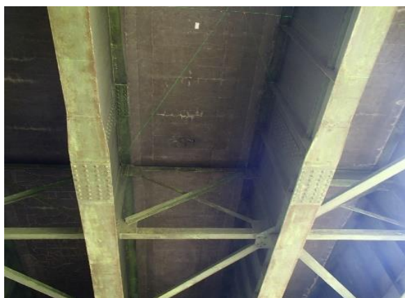
Photo 3 床版下面のコンクリート Deck Slab Underside Concrete
