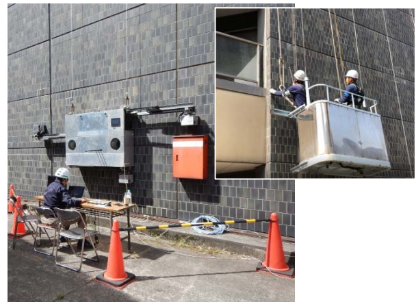
Photo 3 検査状況 (開発システム適用時と常設ゴンドラによる従来検査) Status with the Inspection Methods
