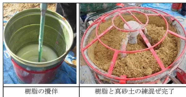
Photo 1 樹脂と真砂土の練混ぜ状況
