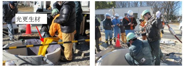
(a) 光更生材の投入 (b) 紫外線照射作業の様子
