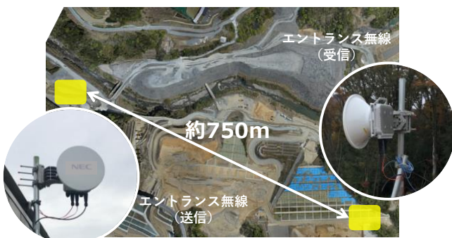
Fig. 11 建機ヤードと遠隔操作室の間を 無線エントランスで接続
