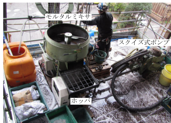
Photo 1 モルタルの練混ぜおよび供給システム Mixing and Supply System of Mortar
