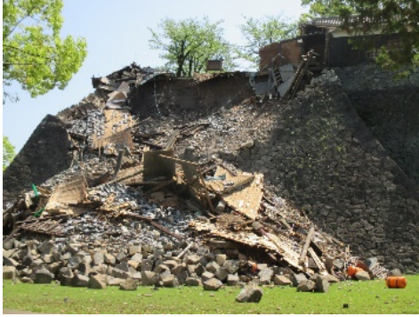
Photo 1 熊本地震における被害例（熊本城・某市庁舎） Damaged Stonewall and a Building in the Kumamoto Earthquake
