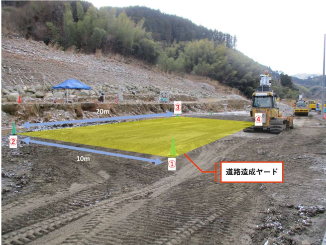
Fig. 16 道路造成前の状況 Situation Before Road Construction
