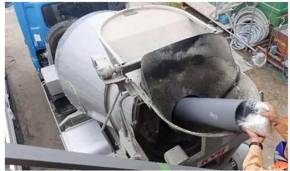
Photo 6 トラックアジテータへの繊維投入状況 Status of Fiber Feeding into Truck Agitator
