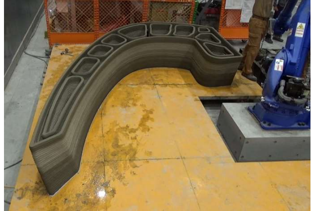
Photo 8 3Dモルタルの積層状況（終了時） Printing of 3D Mortar (at Finish)
