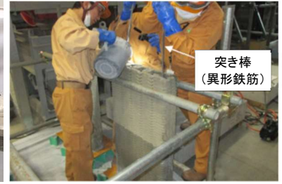
Photo 2 鋼繊維モルタルの打込み Placing UFC
