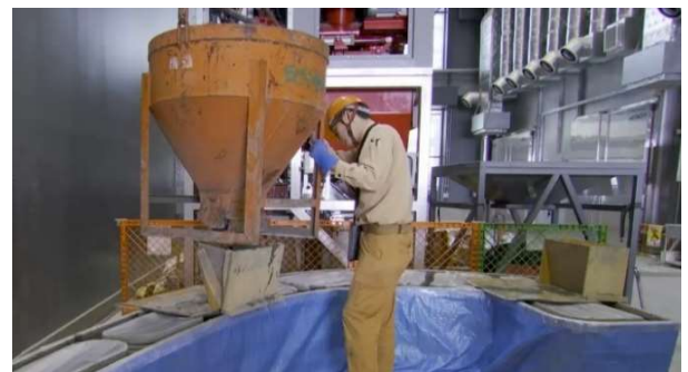
Photo 9 鋼繊維モルタルの打込み状況 Placing UFC
