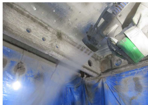
Photo 6 粉じん飛散防止ノズル Dust Scattering Prevention Nozzle
