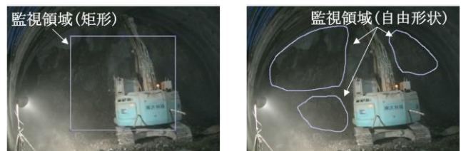
Fig. 5 監視領域の設定 Setting Monitoring Area
