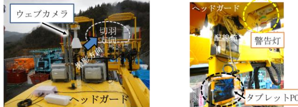
Photo 6 ロックフォールファインダーの設置状況 (Cトンネル，左は重機後方，右は運転席から撮影) Rock Fall Finder Installation Example (C Tunnel)
