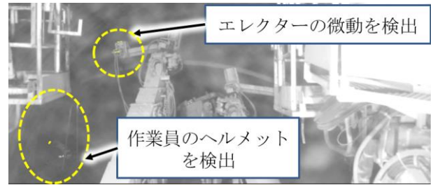
Photo 7 エレクターと作業員を検出した例 Example of Detecting the Erector and the Worker
