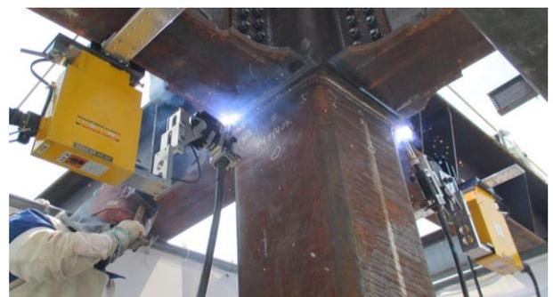
Photo 5 現場ロボット溶接工法の適用状況
