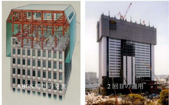
Fig. 2 全自動ビル建設システムの開発<sup>3)</sup>
