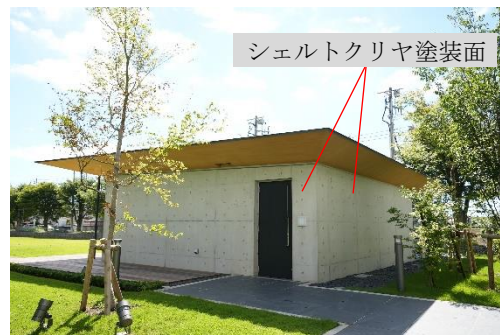
Photo 2 シェルトクリヤの仕上がり状態 Finished State of Shelt-Clear
